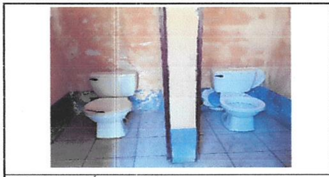
FOTO 5: REPARACIÓN DE SANITARIOS
